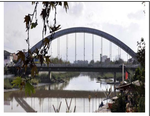
پل کابلی بابلسر بر روی رودخانه بابلرود
