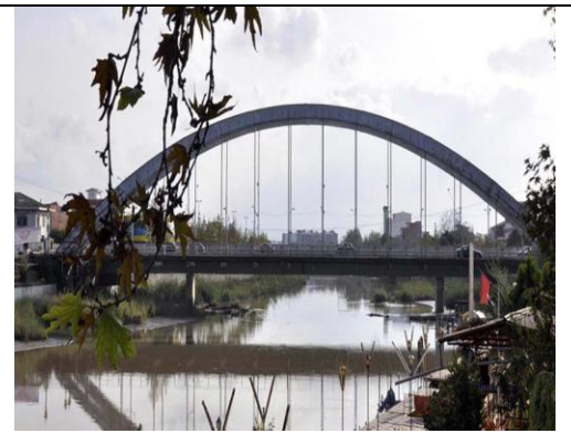
پل کابلی بابلسر بر روی رودخانه بابلرود
