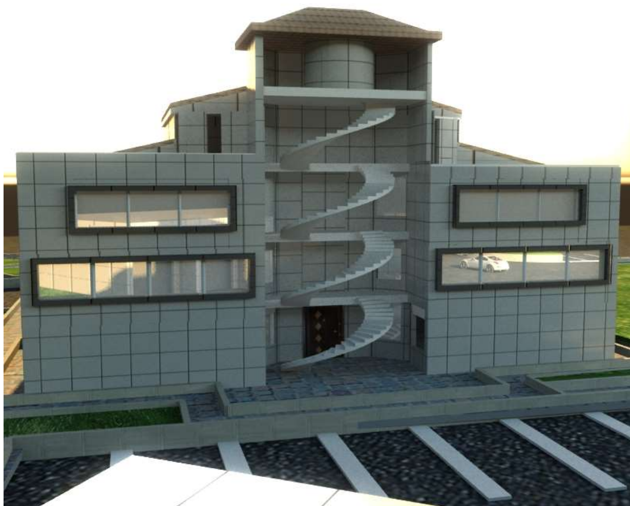
ساختمان اداری مجتمع
